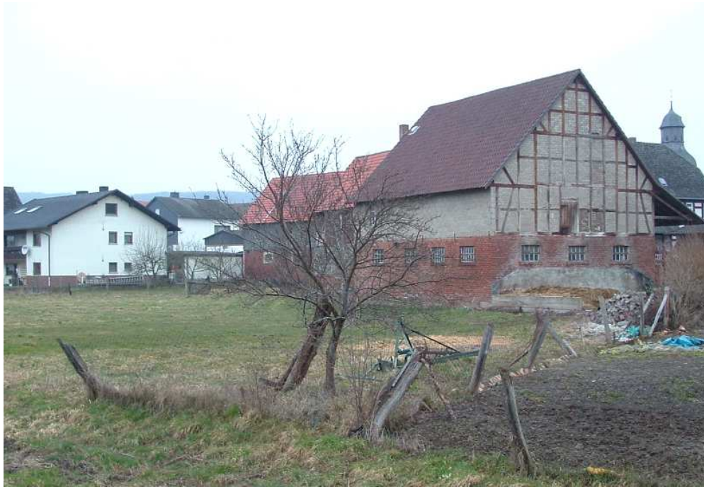
Blick von der Versbachbrücke (Giessener Landstraße) auf das Gelände des ehemaligen Grabenhofes (Foto : Verfasser)
